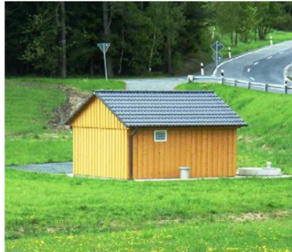
Hochbauteil eines Druckluftpumpwerkes
